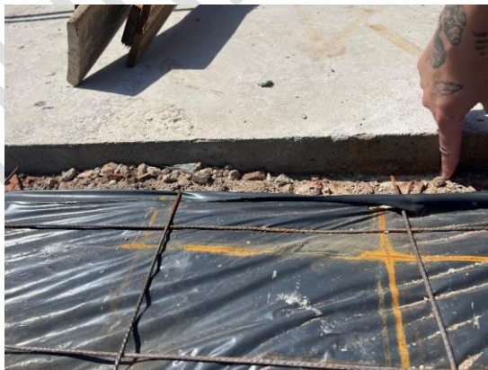
Img. 6 - Espesor base de H° ejecutada por proveedor SLAVON - Fuente: Elaboración propia
